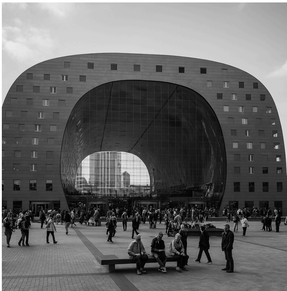
Рис. 1 - Реконструкция рыночного зала в Роттердаме
